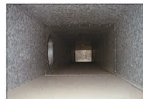
大型ダクト清掃前
