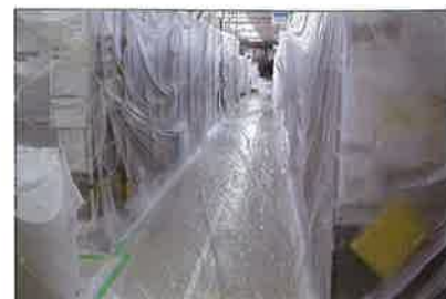
工場室内養生
