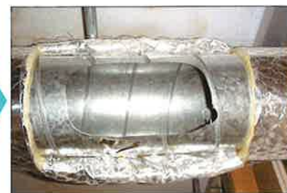
開口後ダクト内部目視確認 (清掃前写真撮影)
