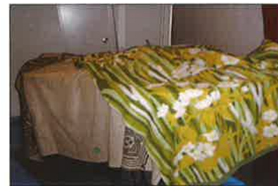
保護養生 (硝子・壊れ物)
