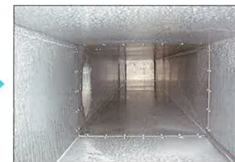
大型ダクト清掃後トリートメント
