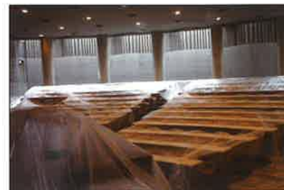
ホール室内養生
