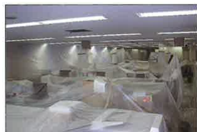
事務所室内養生
