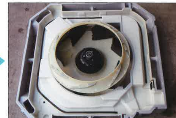
ファン・ドレンパン洗浄後
