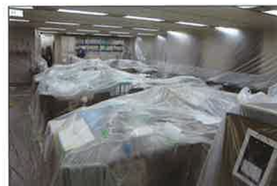
事務所室内養生
