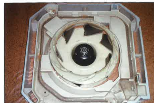
ファン・ドレンパン洗浄前
