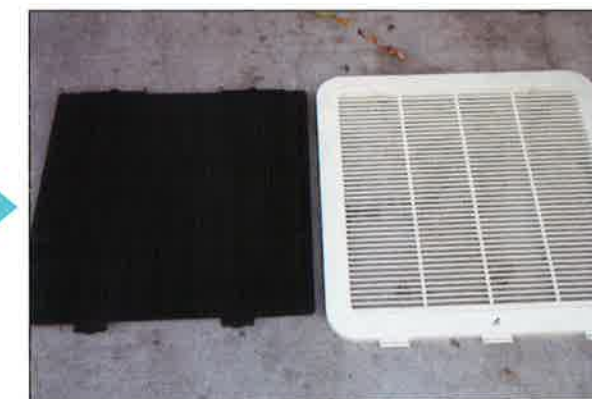
吸込グリル・フィルター洗浄後
