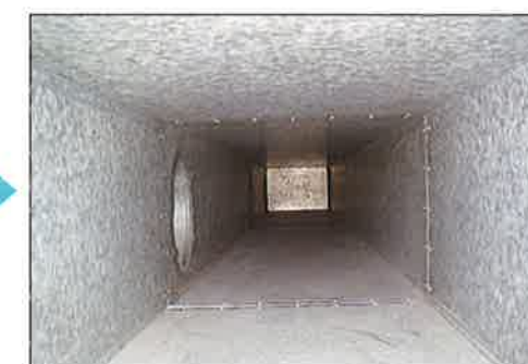
大型ダクト清掃後
